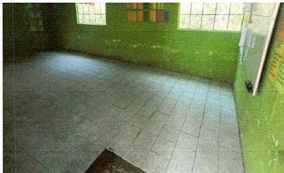
Foto 3: Finalización colocación piso de granito
